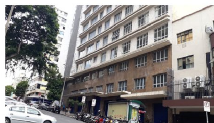
Reforma de imóvel da SRTb/MG
