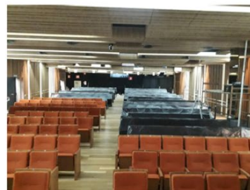
Reparos no Auditório Central - Campus NS
