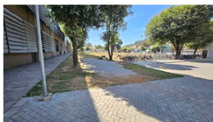
Reforma do Estacionamento - Campus TM
